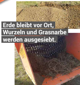
Absieben von Mutterboden am Lagerplatz.
