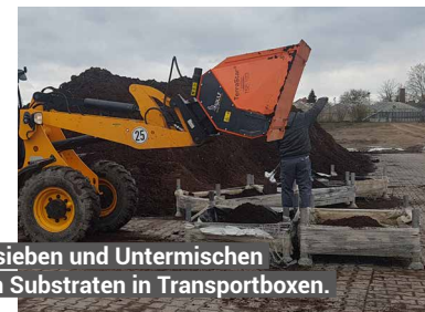
Absieben von Mutterboden am Lagerplatz.
