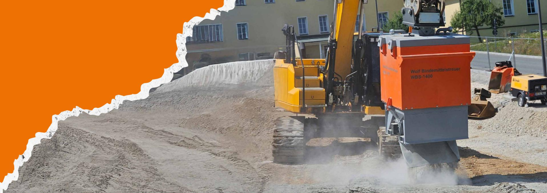
Bindemittel/Kalkstreuer werden auf Baustellen eingesetzt, um die Zuschlagstoffe wie Kalk oder Kalk-Zementgemisch dosiert und gezielt auf das Erdreich aufzubringen. Das sogenannte Bindemittel trocknet die Erde und macht sie so wieder verwendbar. Am besten in Verbindung mit einem Schaufelseparator, der die Erdklumpen zerkleinert, aufschließt und den Mischbinder mit hohem Durchsatz untermischt. So bearbeitete Erden ist homogen und trocken und kann so wieder eingebaut und verdichtet werden.
