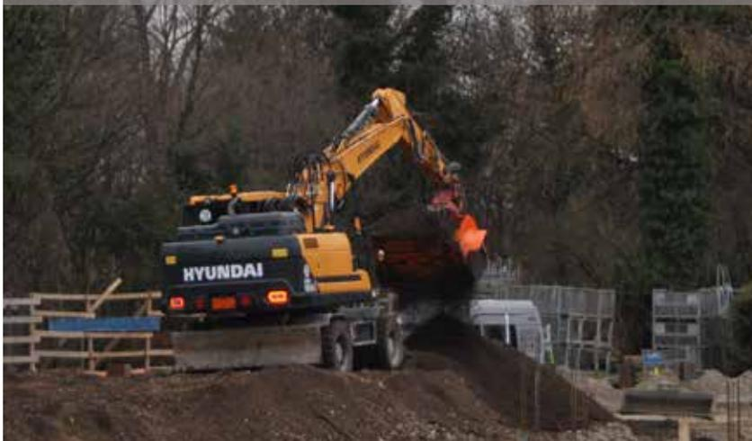
Kalk untermischen mit der Mischwelle M80X - zur Bodenstabilisierung
